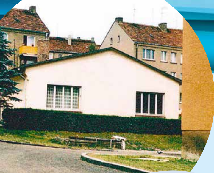
Die Geschäftsstelle der WGM vor und nach dem Umbau
